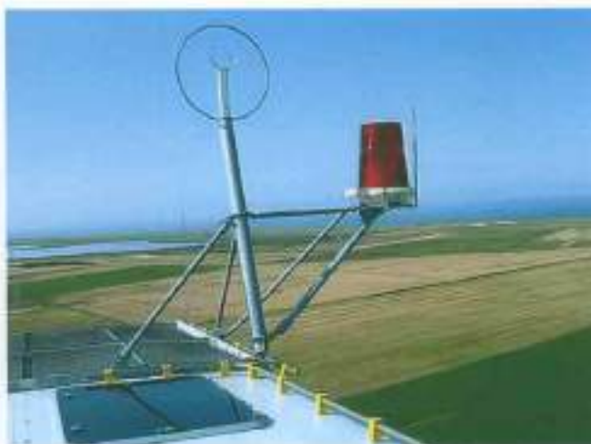
Figura 17: Pamje të anemometrave ultrasonik dhe dritave të dritave të aviacionit, montuar tek dhoma e motorit
