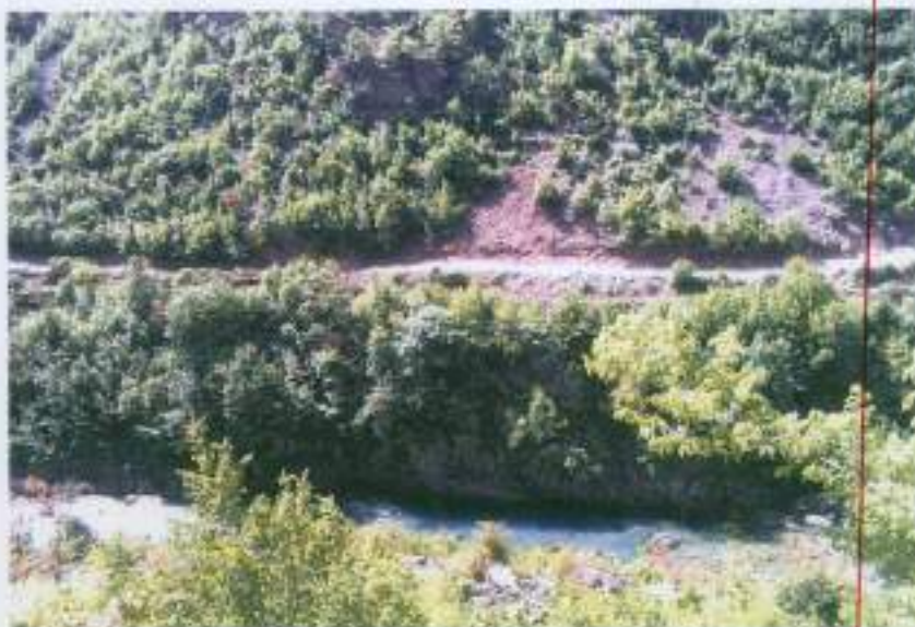
Figura 10 – Panje e përroit të Germanit në Akcizë Tubacioni të Turbinës HEC Germani 7 – meti i Malet
