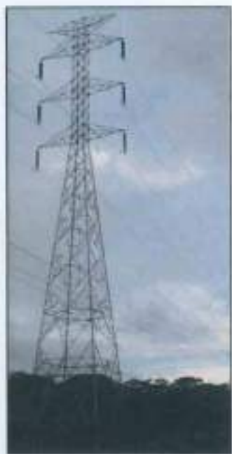
Figura 1- Konfiguracionet e linjës: qark i dyfishtë 220 kV (majtas) dhe qark i vetëm 110 kV (djathtas)
