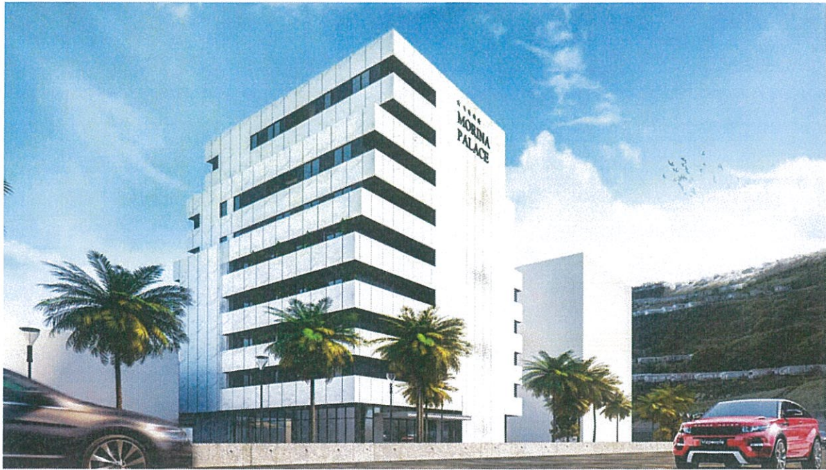
Fig. 7 Imazh i objektit përgjatë rrugës.
