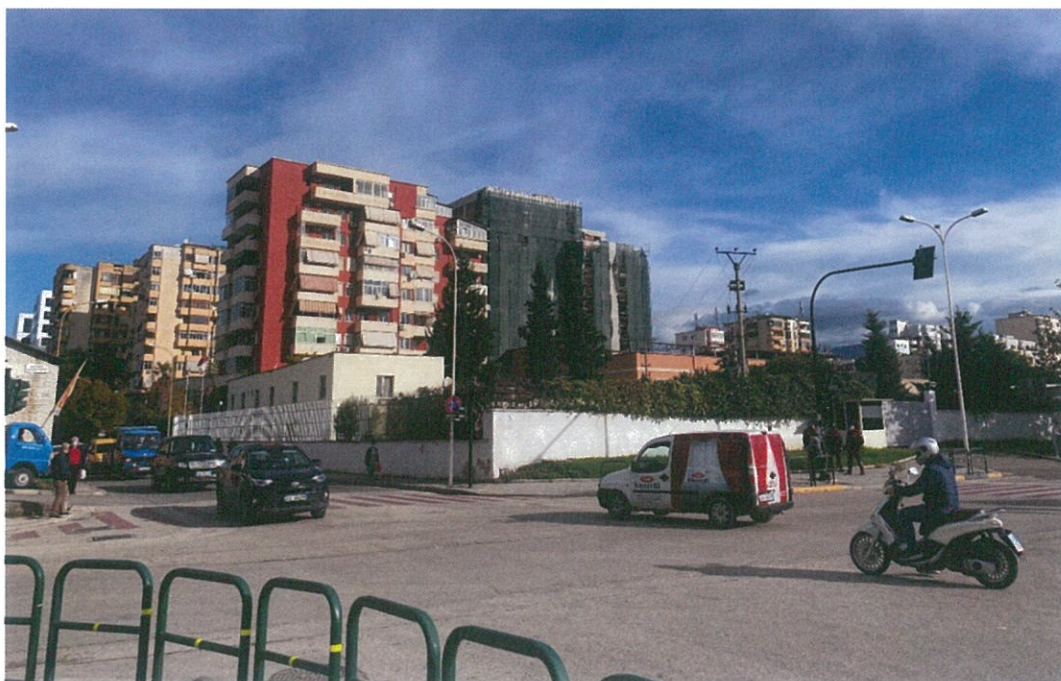
Fig.6 Foto të gjëndjes ekzistuese
