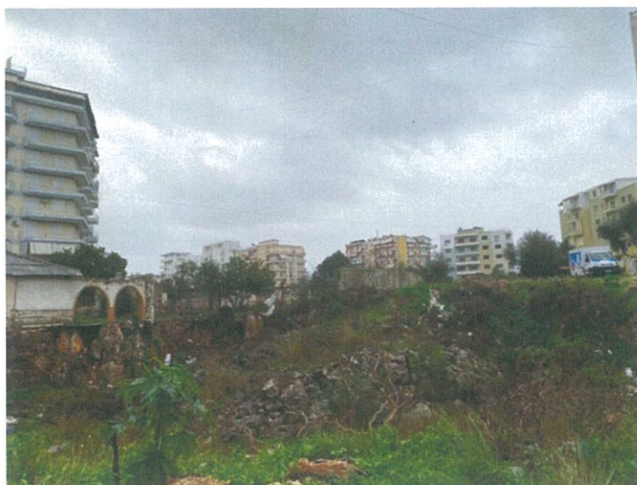
Fig. 4 – Foto e gjendjes ekzistuese të truallit
