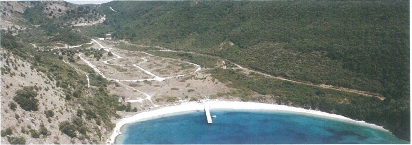
Fig.8 Foto të gjëndjes ekzistuese
