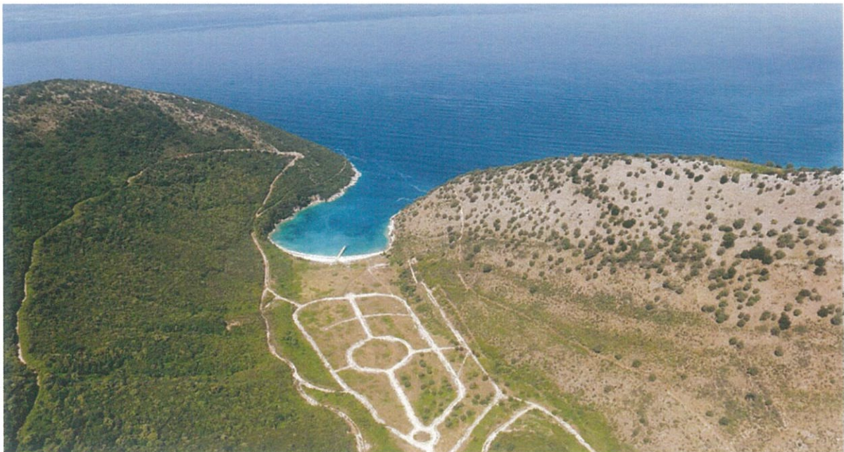
Fig.7 Foto të gjëndjes ekzistuese
