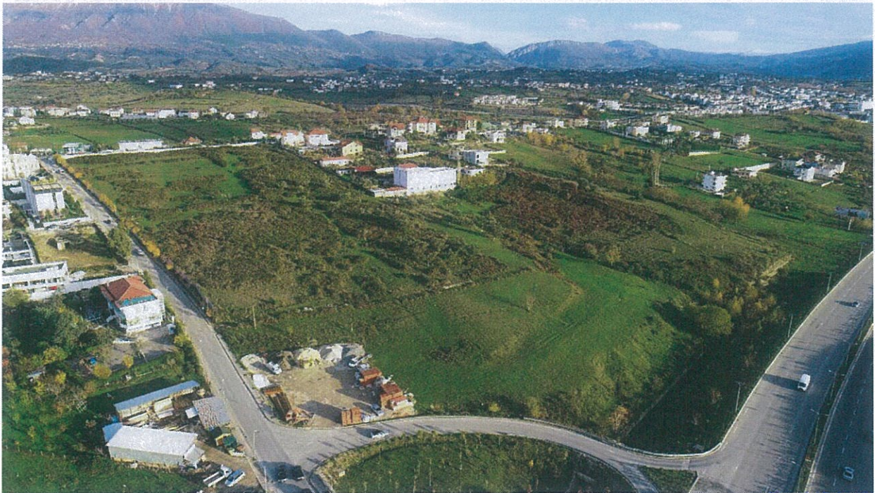
Fig.05 Foto të gjendjes ekzistuese
