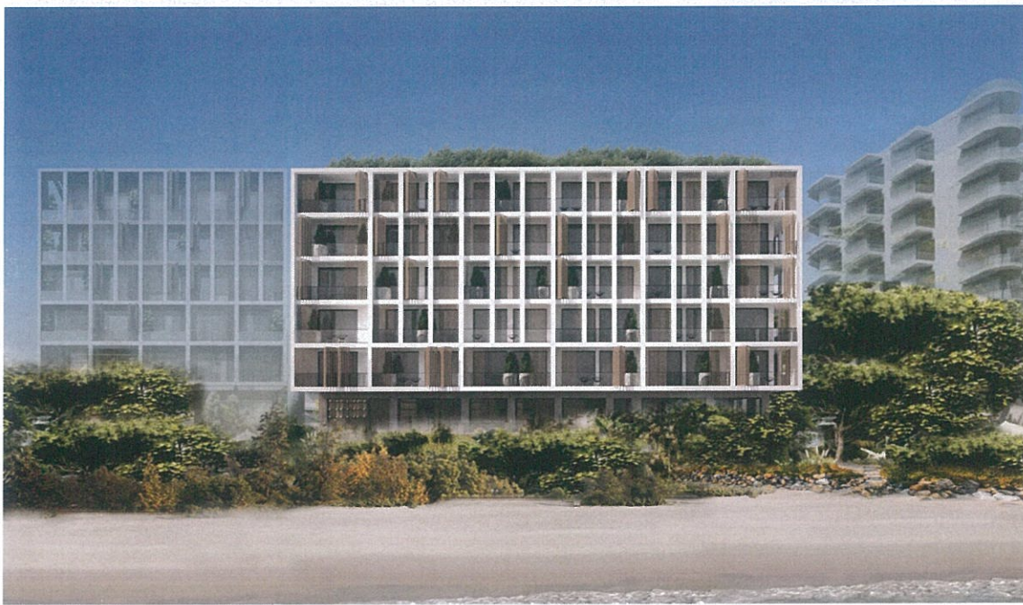
Fasada e objektit .
