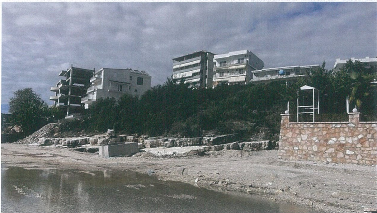
Fig.2 Foto e sheshit të ndërtimit.
