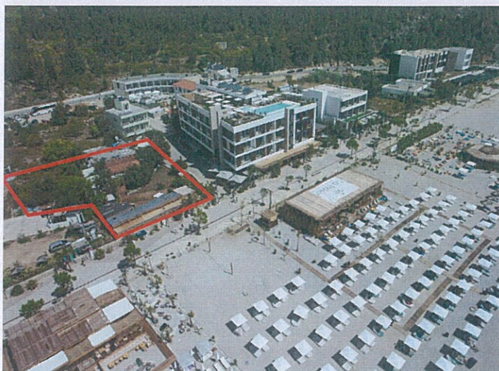
Fig.7 Foto e sheshit të ndërtimit.
