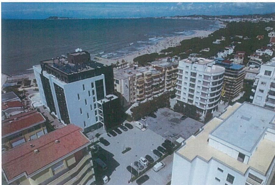
Fig.3 Foto të gjendjes ekzistuese
