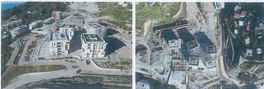
Fig.9 Foto të sheshit të ndërtimit.
