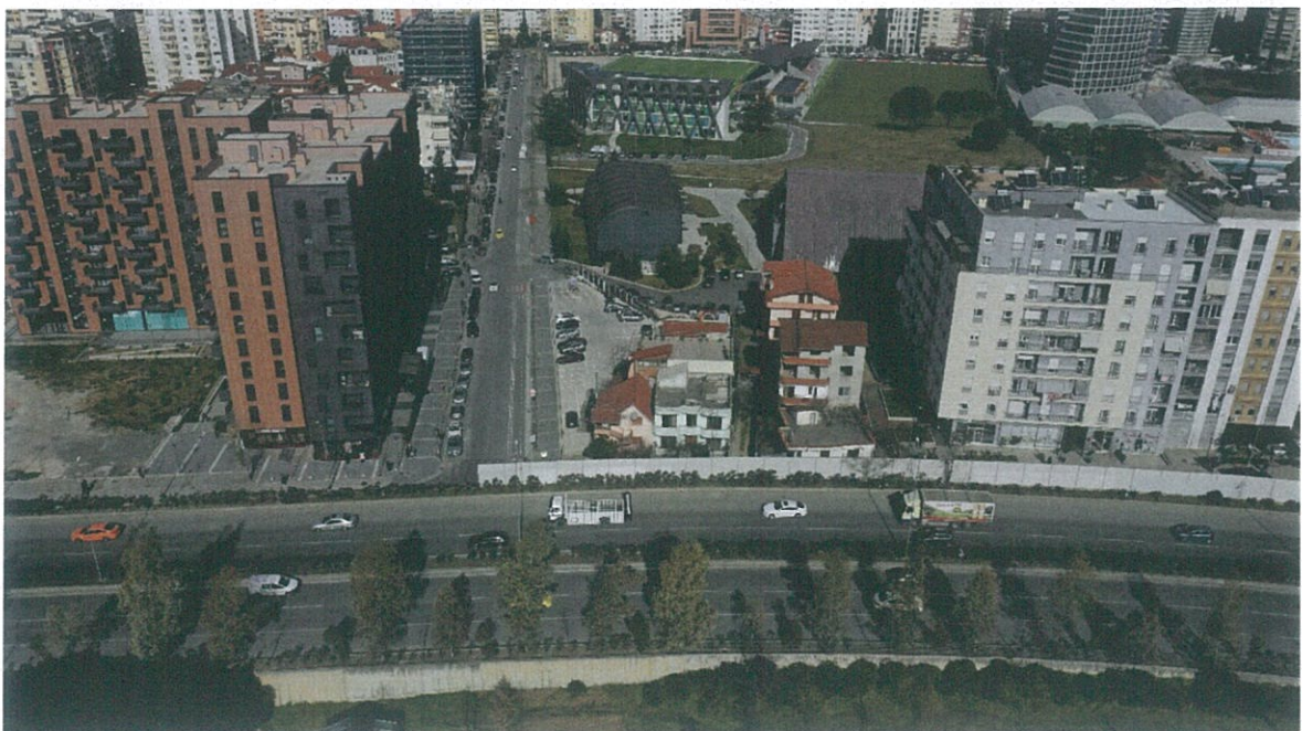
Fig. 5 – Foto e gjendjes ekzistuese të truallit
