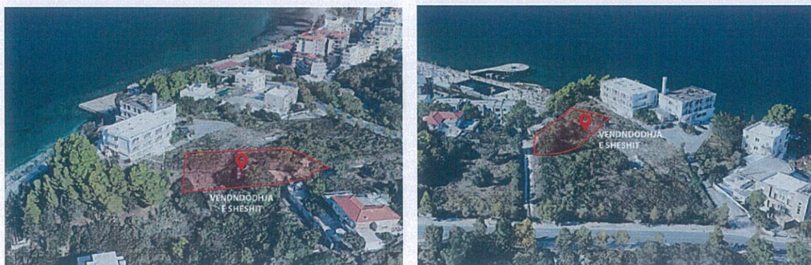
Fig.8 Foto të sheshit të ndërtimit.
