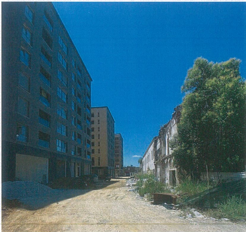
Fig. 4 – Foto e gjendjes ekzistuese
