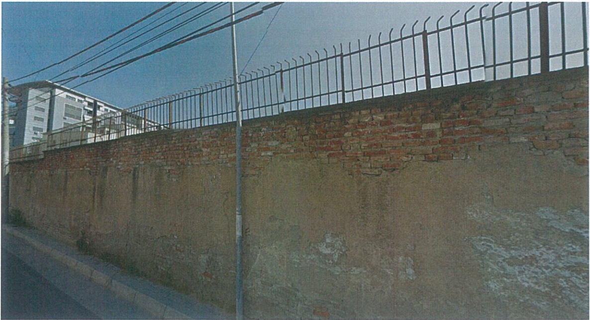
Fig. 3 – Foto e gjendjes ekzistuese
