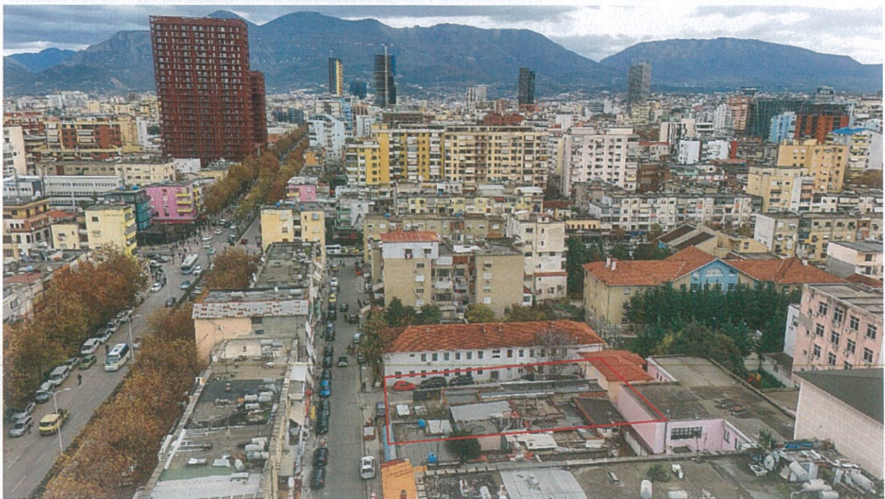
Fig. 8 – Foto e gjendjes ekzistuese të truallit
