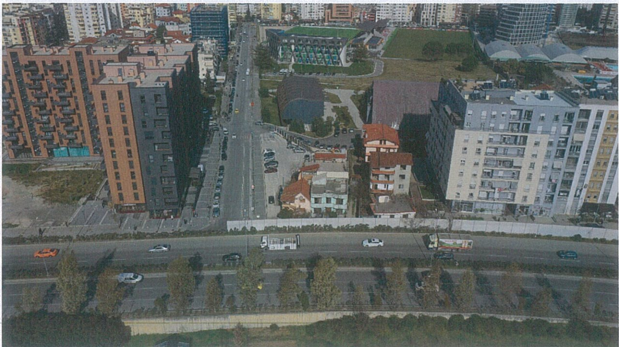
Fig. 5 – Foto e gjendjes ekzistuese të truallit
