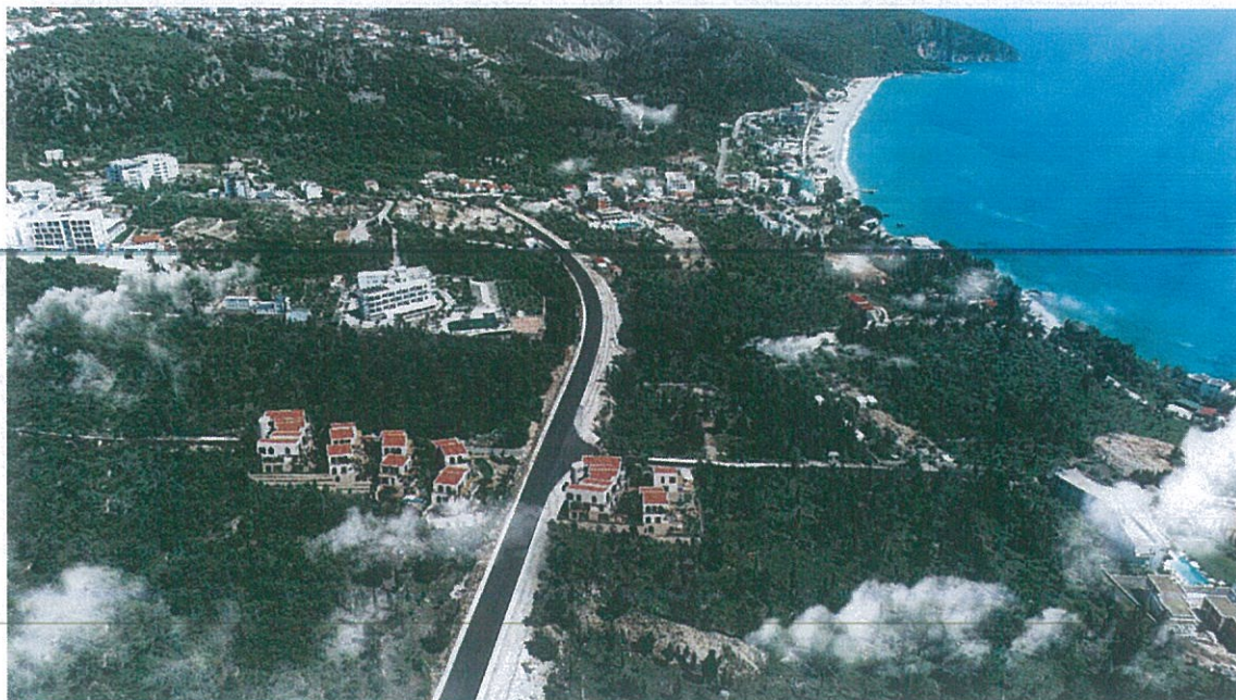
Fig. 10 Imazh i objektit përgjate rrugës.
