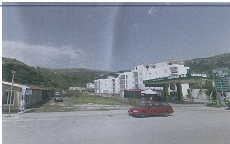
Fig 7. Foto e gjendjes ekzistuese
