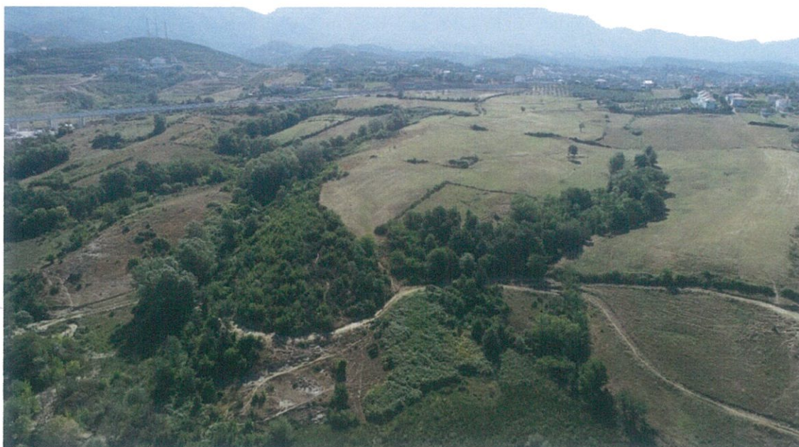
Fig.9 Foto e gjendjes ekzistuese
