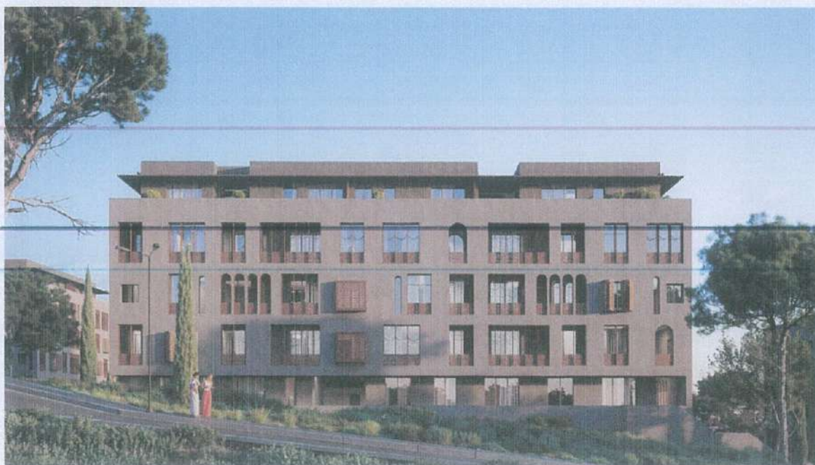
Figura 21 Pamje e Fasades, Objekti F
