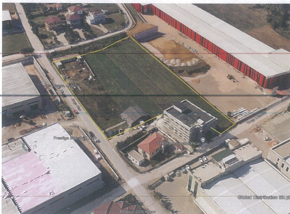
Fig. 3. Foto e gjendjes ekzistuese.
