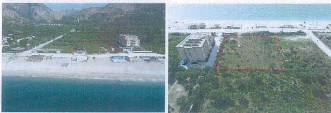
Fig.8 Foto e sheshit të ndërtimit.
