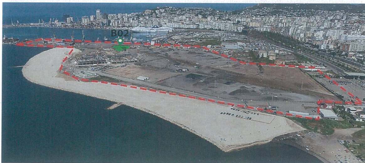
Fig.11 Foto e sheshit të ndërtimit.
