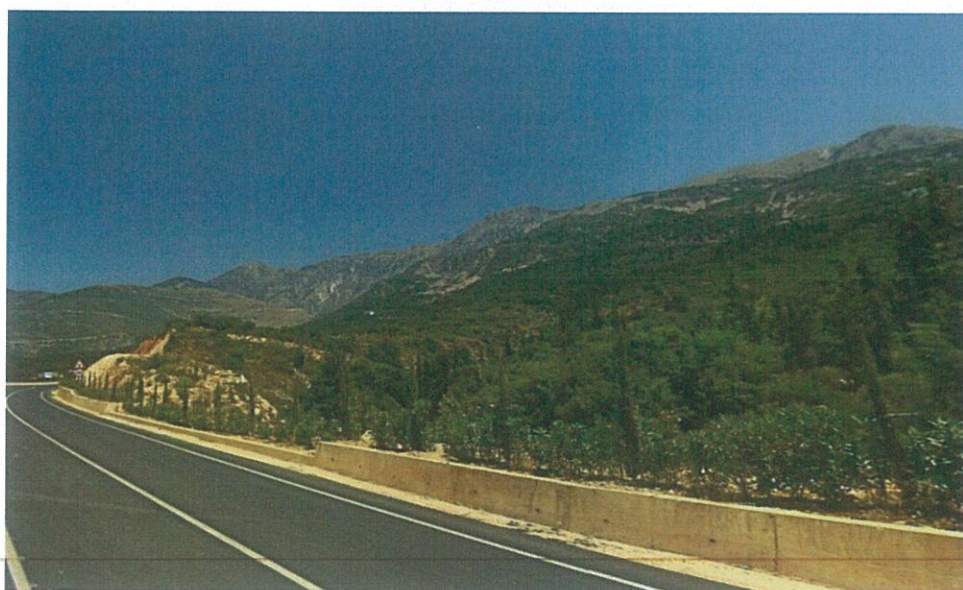
Fig.5. Foto e gjendjes ekzistuese
