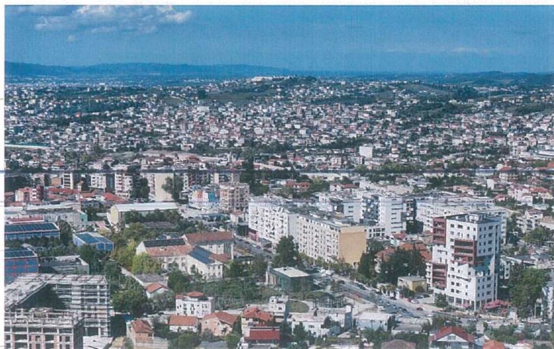
Fig.8 Foto e gjendjes ekzistuese.
