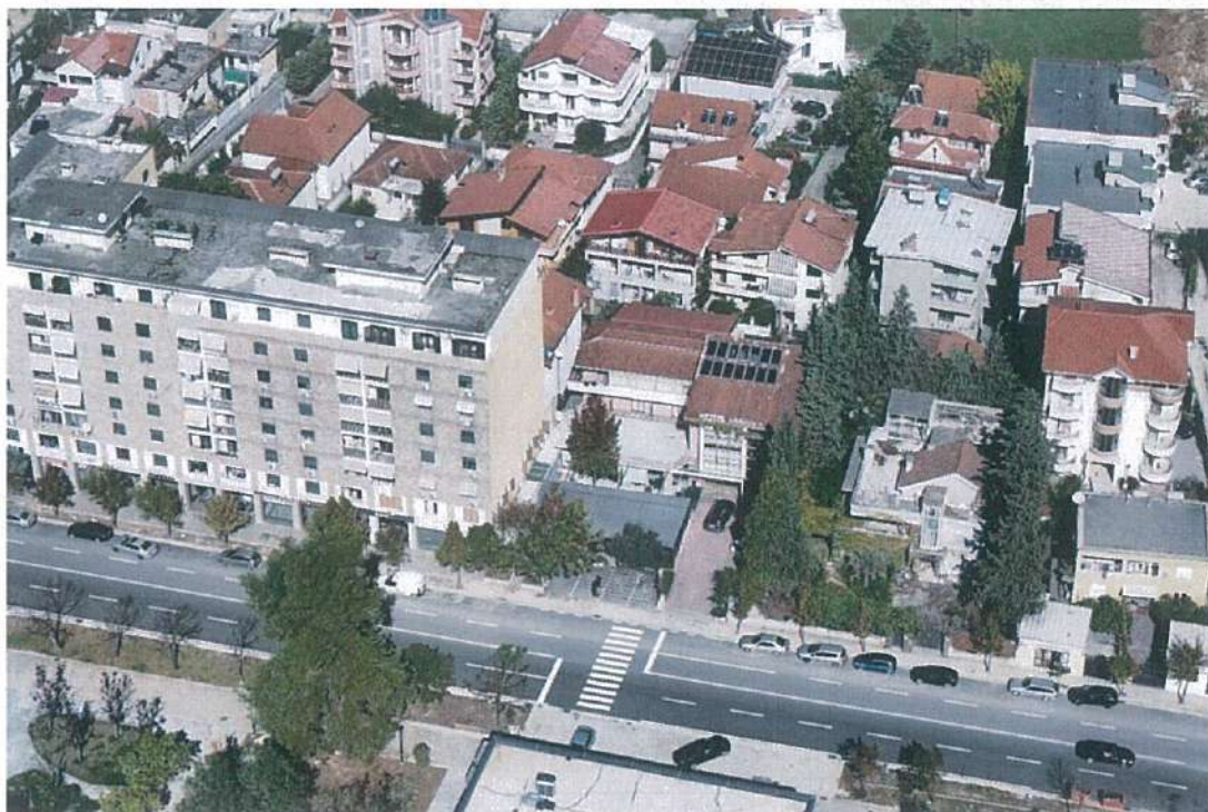
Fig.7 Foto e gjendjes ekzistuese.
