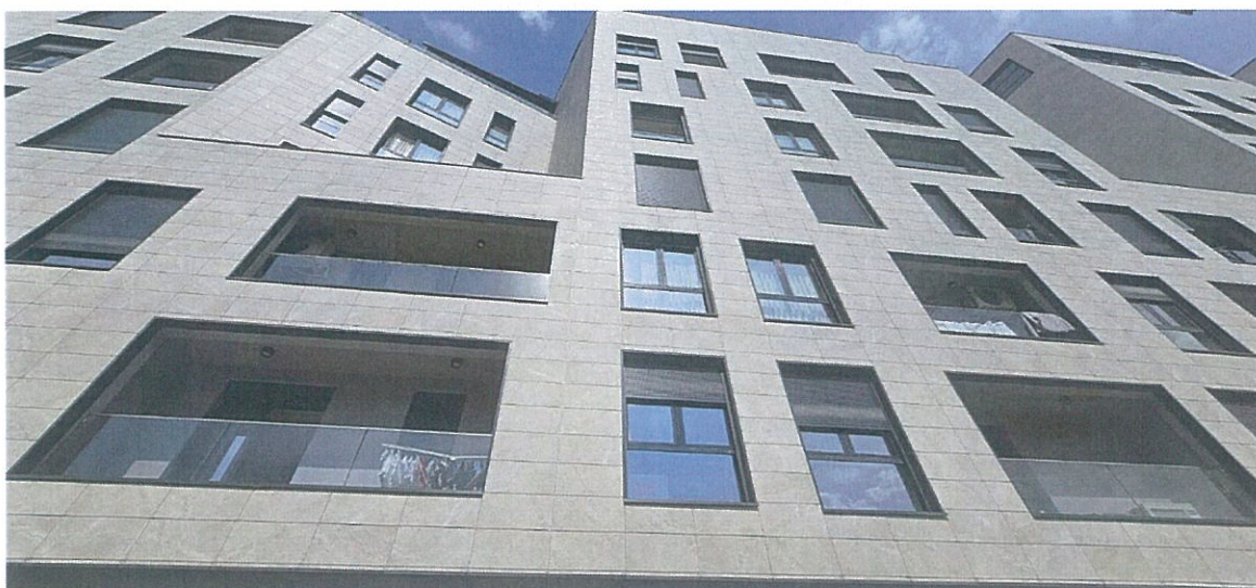
Foto -Fasada e ventiluar
