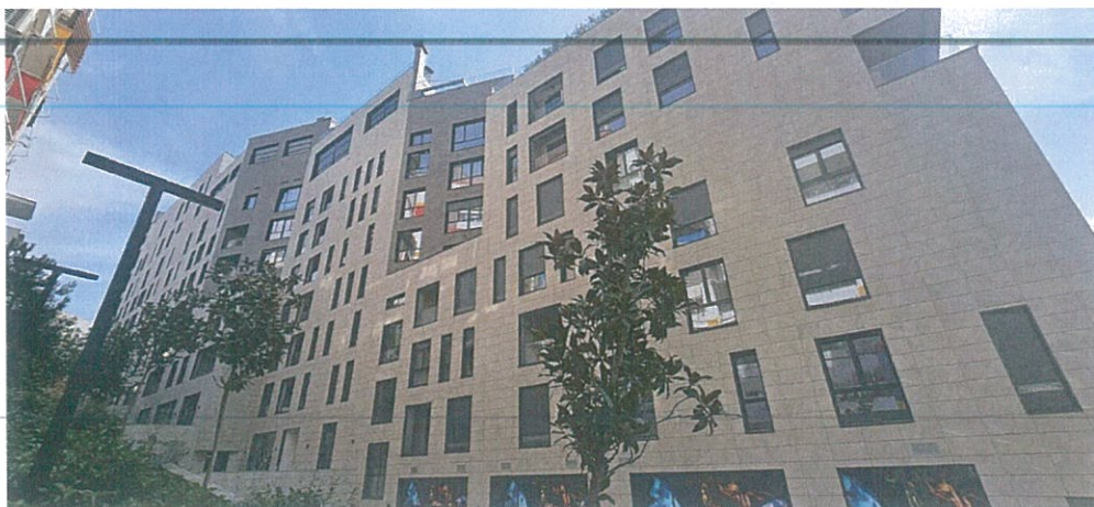
Foto te fasadas se ventiluar
