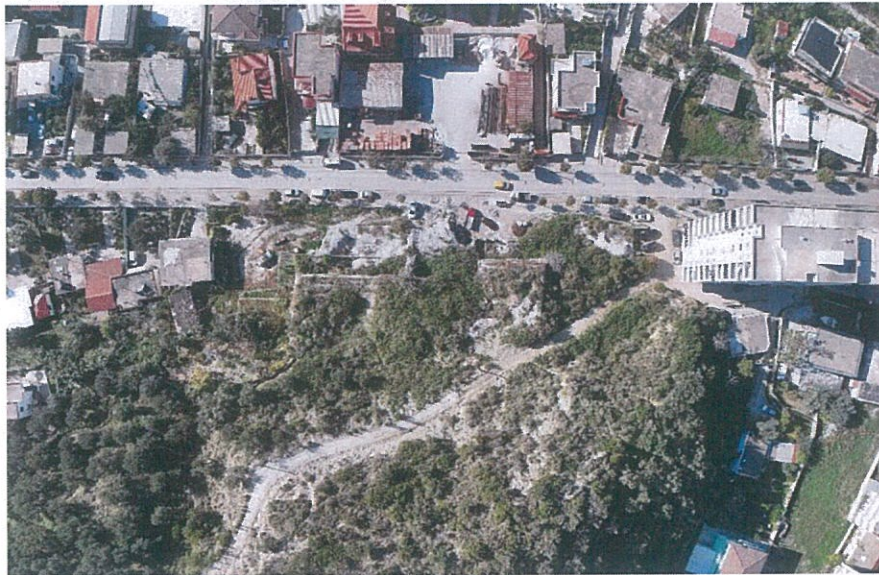
Figura 4. Pamje nga gjendja ekzistuese e truallit
