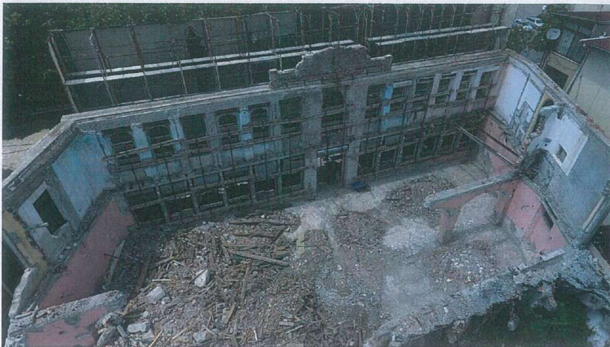
Figura 7 Foto ajërore të fasadës së vjetër të objektit ekzistues
