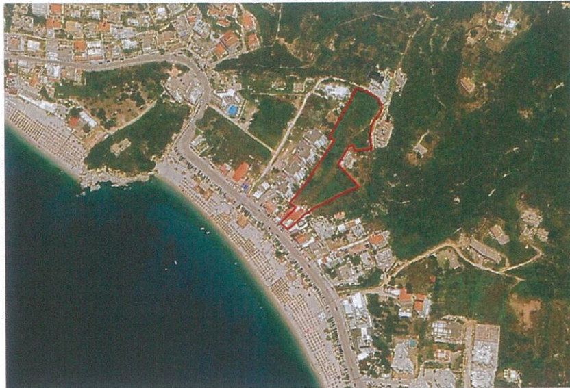
Fig.8 Foto e sheshit të ndërtimit.
