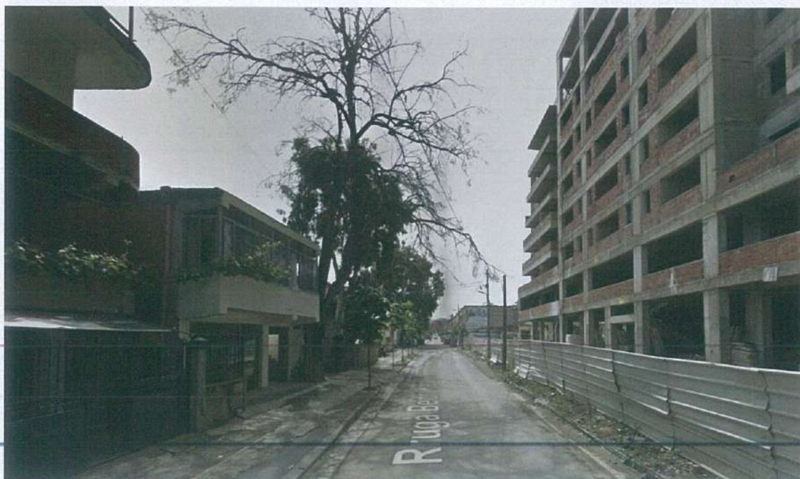
Fig. 6 - Foto e gjendjes ekzistuese të truallit
