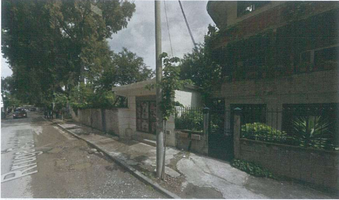
Fig. 7 - Foto të gjendjes ekzistuese të truallit
