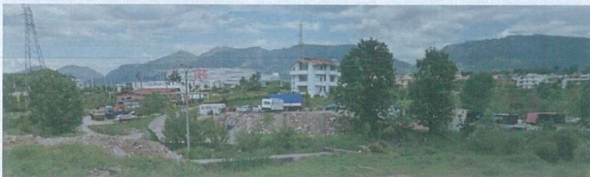
Fig. 8. Foto e gjendjes ekzistuese.
