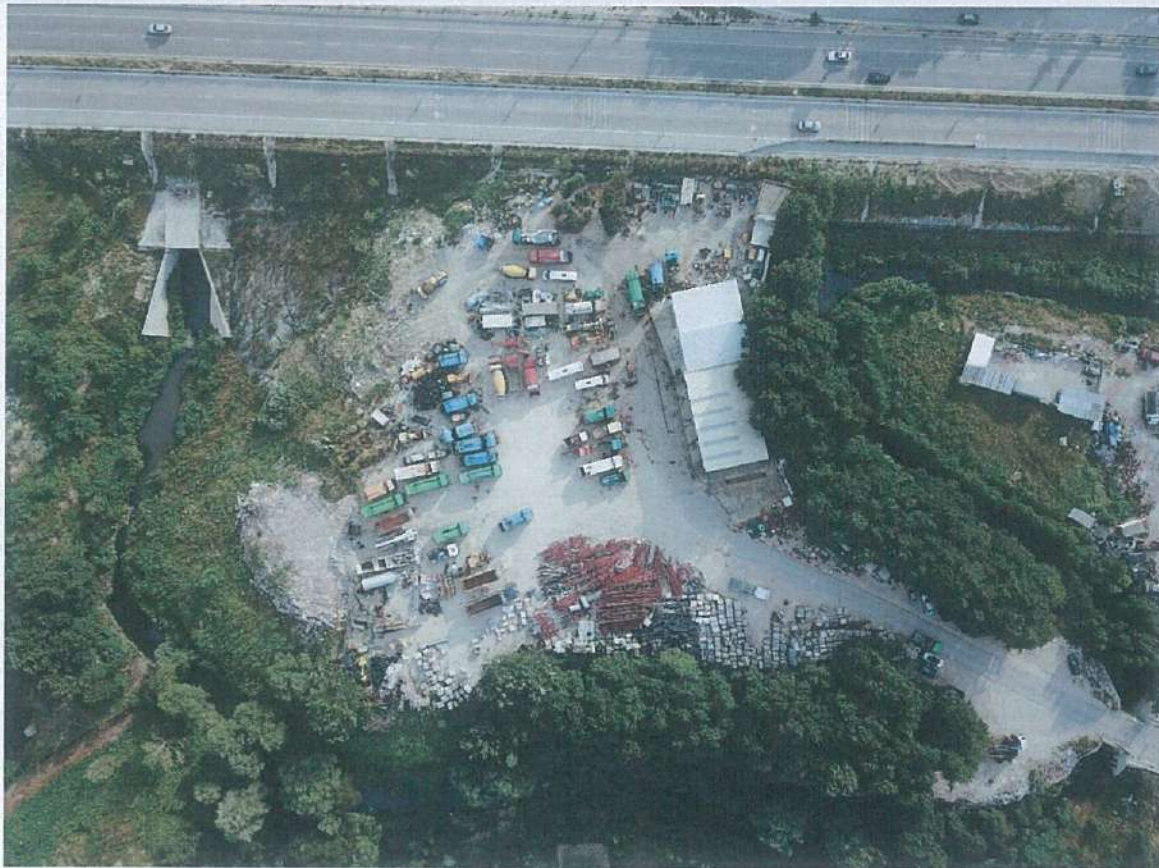
Fig. 9. Foto e gjendjes ekzistuese.
