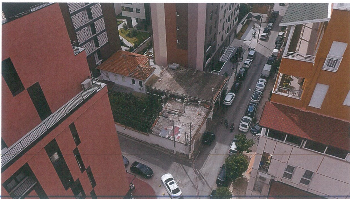
Fig Nr. 5: Foto e gjendjes ekzistuese nga Rruga "Dervish Hekali"
