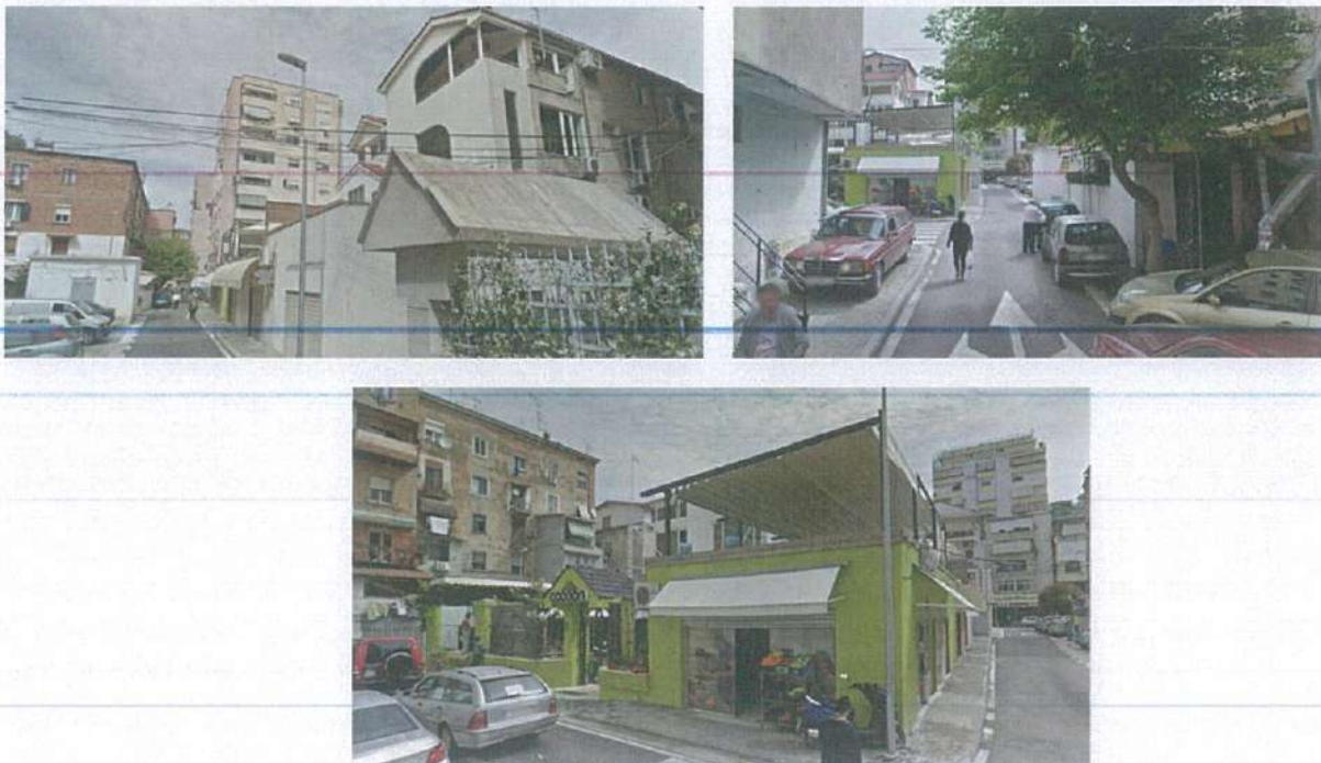
Fig.6 Foto e gjendjes ekzistuese
