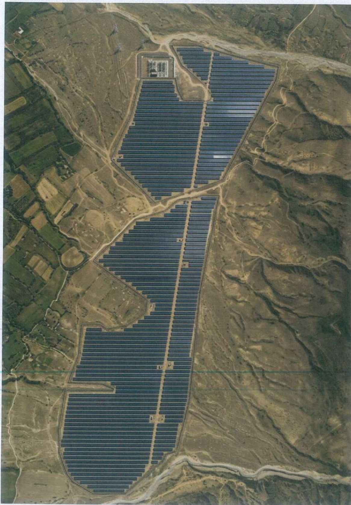
Figure 8: Pamje e implantit fotovoltaik
