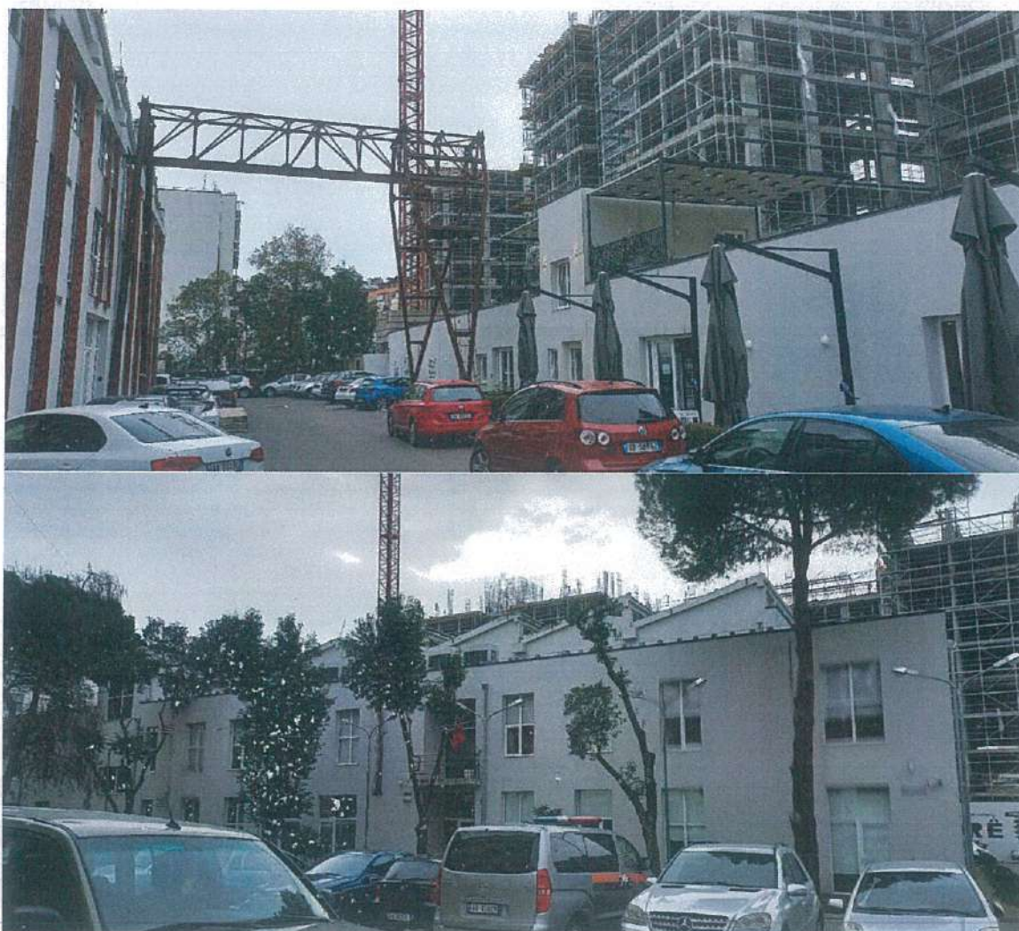
Fig. 5. Foto të gjendjes ekzistuese
