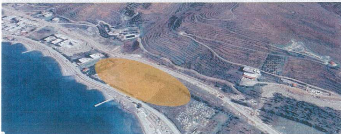
Figure 8. Foto e gjendjes ekzistuese
