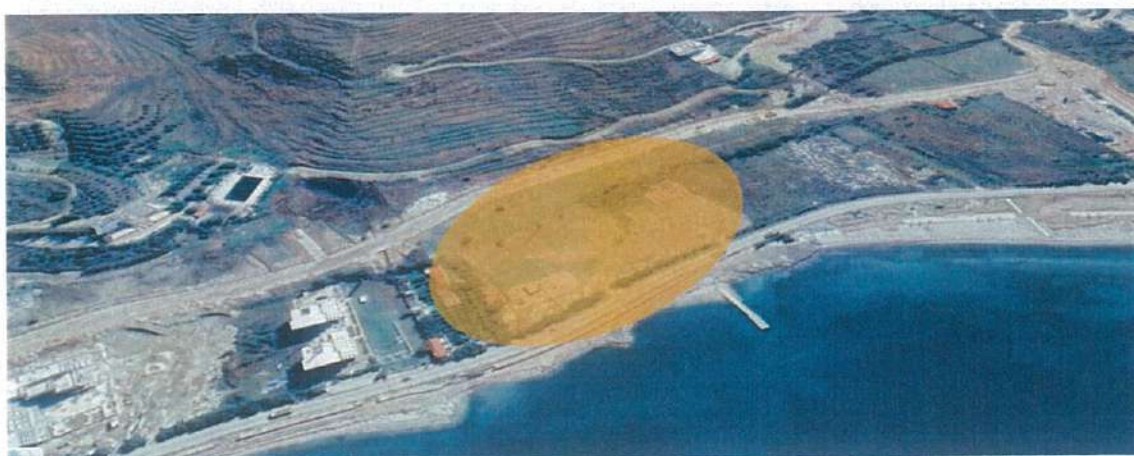
Figure 6. Foto e gjendjes ekzistuese
