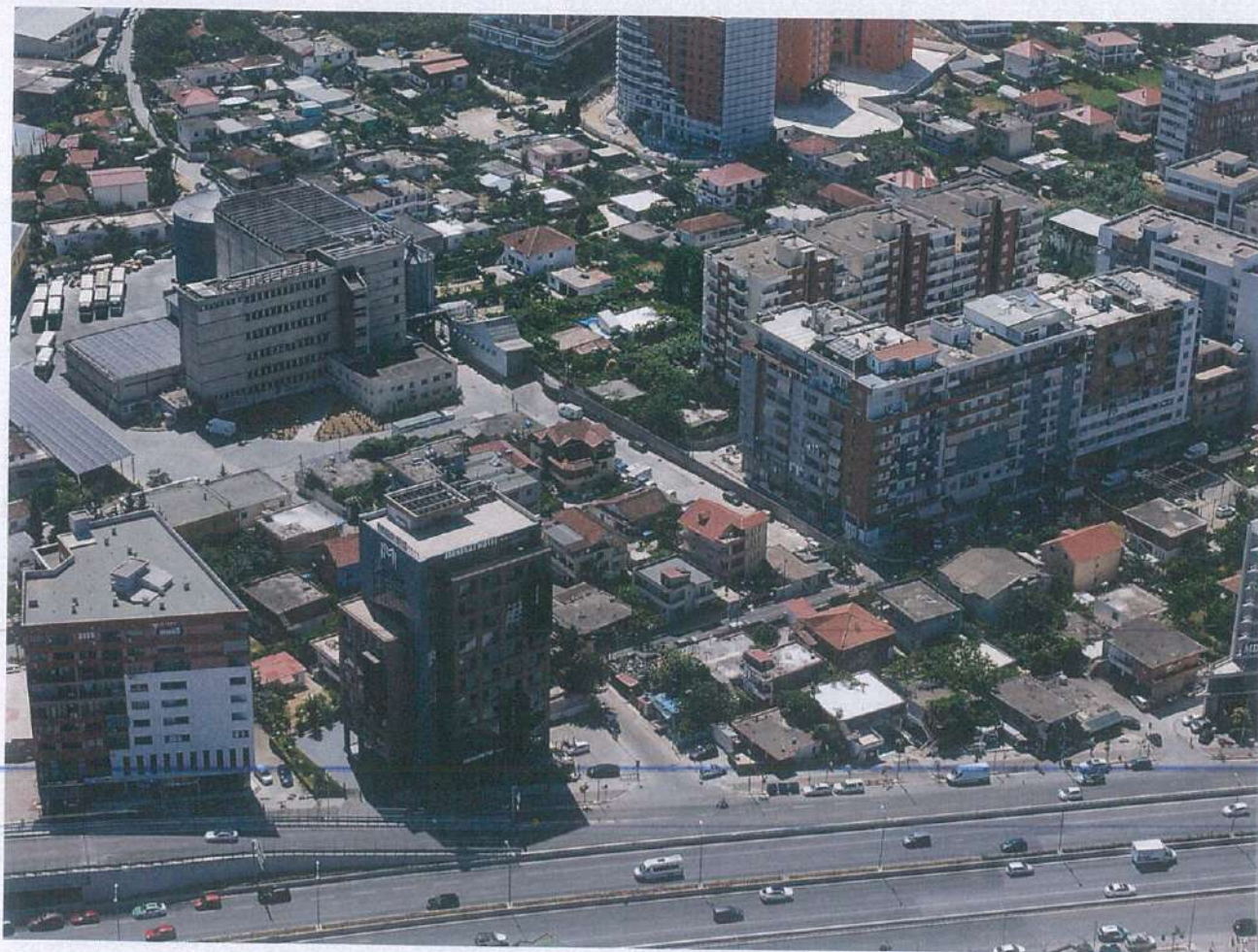
Fig. 3 - Foto e gjendjes ekzistuese
