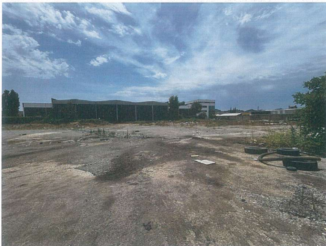
Figura 10 Foto të gjendjes ekzistuese
