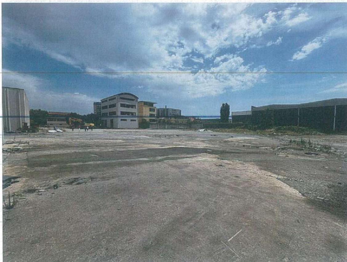
Figura 11 Foto të gjendjes ekzistuese
