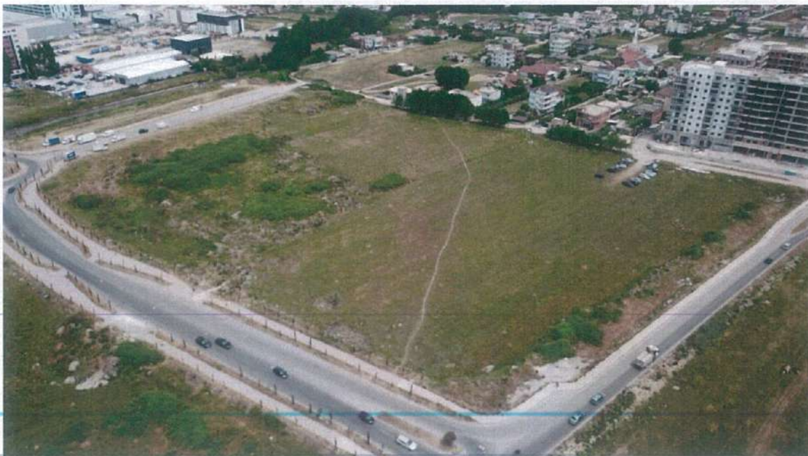
Fig. 5: Pamje të gjendjes ekzistuese
