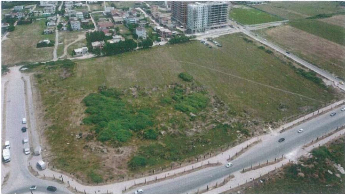
Fig.4: Pamje të gjendjes ekzistuese
