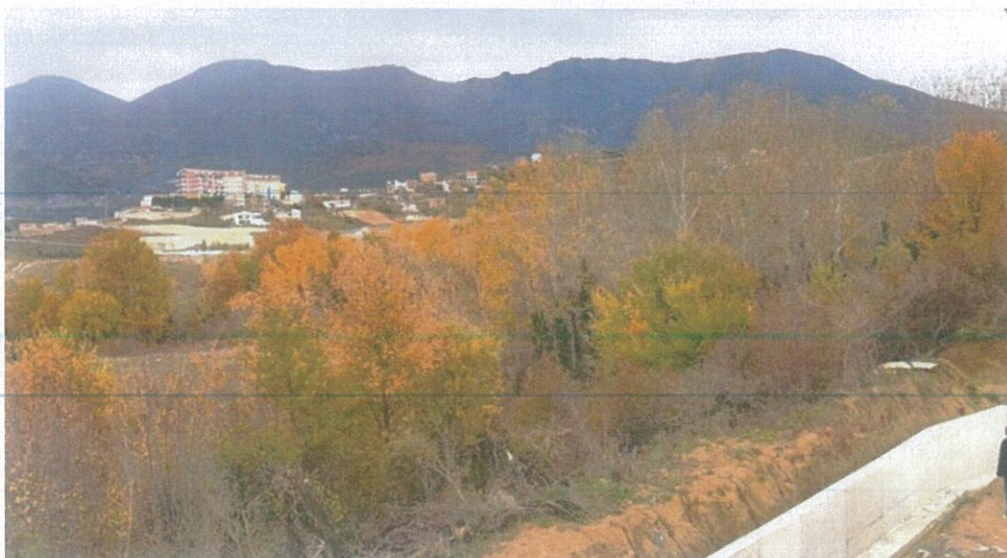
Fig.8 Foto të gjendjes ekzistuese
