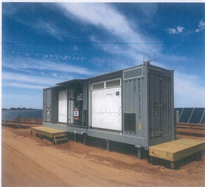
Figure 7 Pamja e kabinave elektrike , konteniere te parapergatitur
